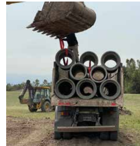
2022 Ingreso e instalación de tubos
