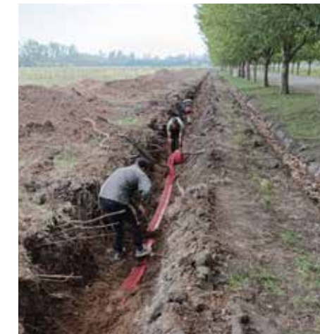
2022 Excavación y apertura de zanjas
