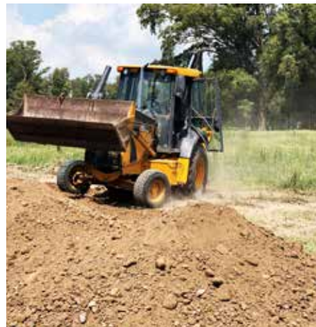
2021 Inicio de obras
