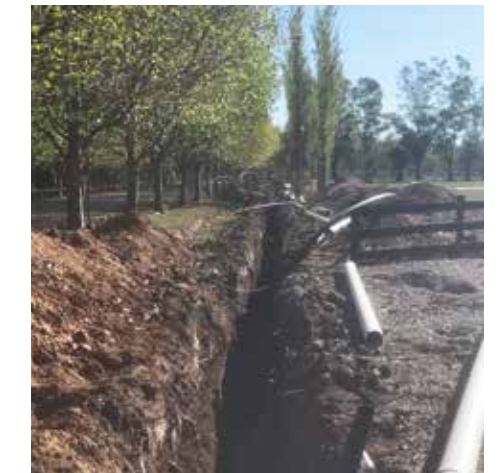
2022 Conexiones: Cloaca 2023 Agua y electricidad
