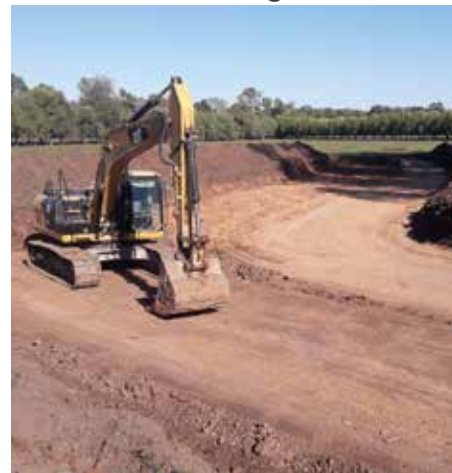
2021 Apertura de Cul de Sac y Excavación de la laguna
